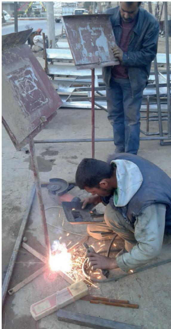
Lavoro di riparazione a uno dei piccoli "leggii": saldatura della struttura metallica e ridipintura
