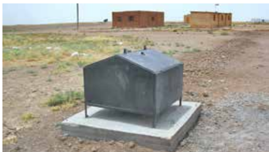
Installazione del sistema di acqua corrente a Mozan, estate 2012
