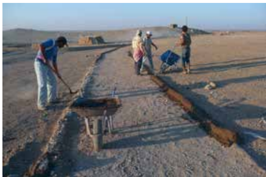
Il tracciato del percorso è formato da un semplice strato di ghiaia
