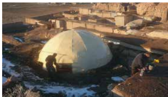
La copertura di metallo pronta per la prima neve
