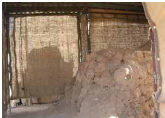
Un muro nel suo stato di erosione come era quando scavato
