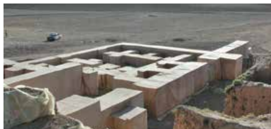
Il sistema di protezione dei muri rende nel suo insieme la struttura architettonica del palazzo
