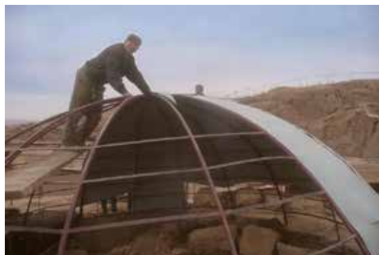
Installazione della copertura di metallo sulla cupola dello «abi»
