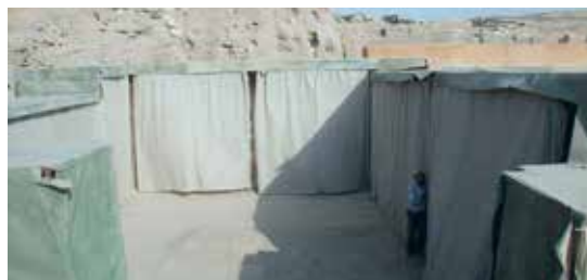
I muri del palazzo con le tende chiuse evidenziano la volumetria originale
